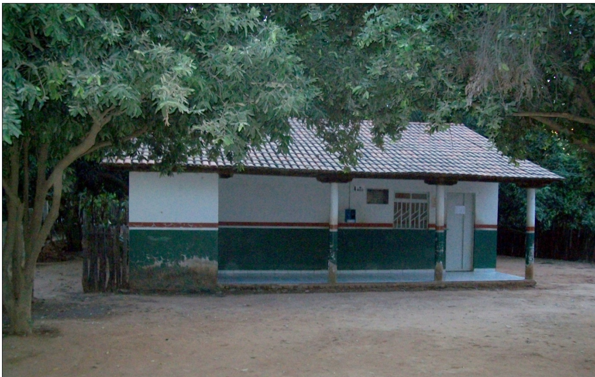
FIGURA 4: Posto de Saúde Rancharia, localizado na aldeia Rancharia, sede do Pólo de Saúde Rancharia
