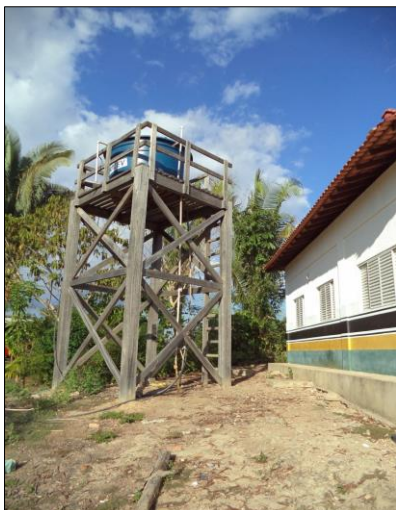
Figura 29 – Reservatório da escola Fonte: A autora, 2018.
