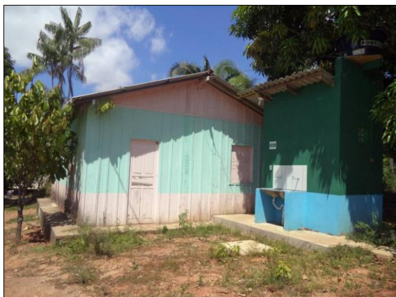
Figura 34 – Banheiro externo à residência, à direita (A)
